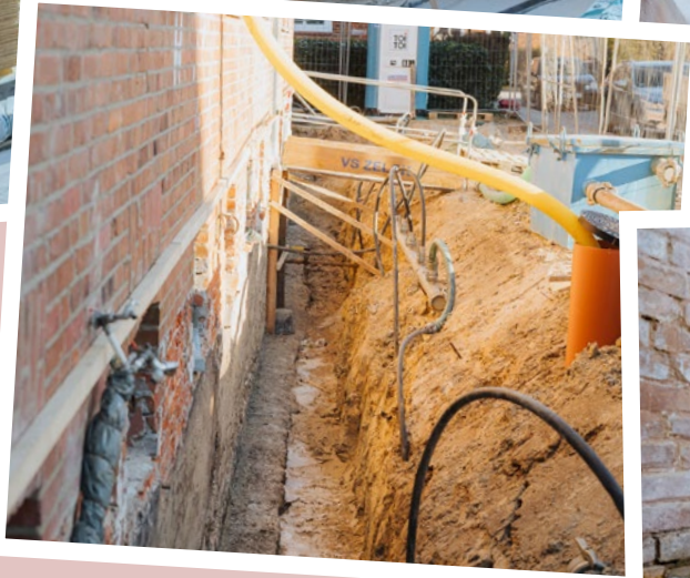
Impressionen von der Baustelle in der Lortzingstraße 9 und 10.
