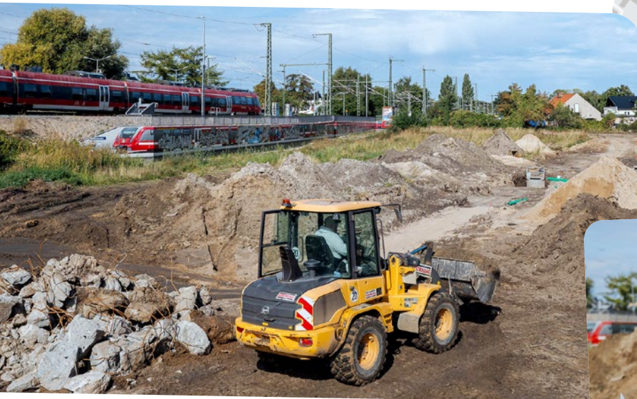
Auf dem ersten Baufeld vom Werftdreieck wird viel Erde bewegt. Rechts: WIRO-Projektleiter Hannes Wilcke
